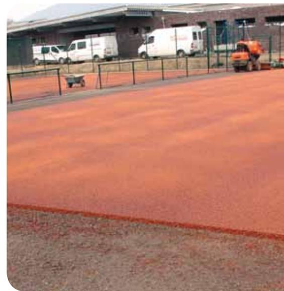
Bahn für Bahn wird der Spezialbelag auf den vorbereiteten Unterground aufgebracht.
