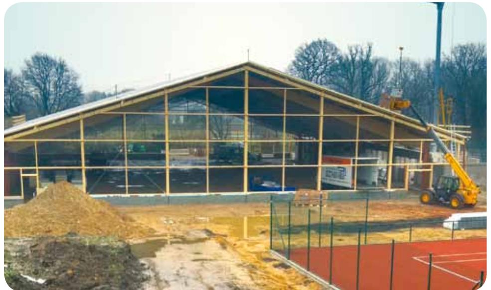
Geschafft! Das Hallengerüst steht, das Dach ist eingedeckt, nun kann auch die Photovoltaikanlage auf der südlichen Dachfläche installiert werden.
